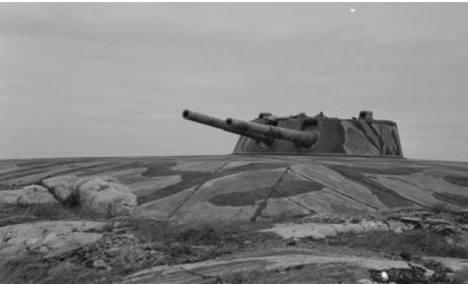
Tykki on 305 mm:n 52 kaliiperin venäläinen merikanuuna mallia Obuhov panssaroidussa tornissa kaksoisasennettuna (305/52 O2). Mäkiluodon linnake, SA-kuva, Sot.virk. Suomela
